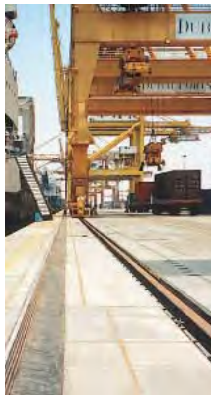
Порт Jebel Ali - Дубаи. Завершённое дооснащение Panzerbelt длиной 1500м.
