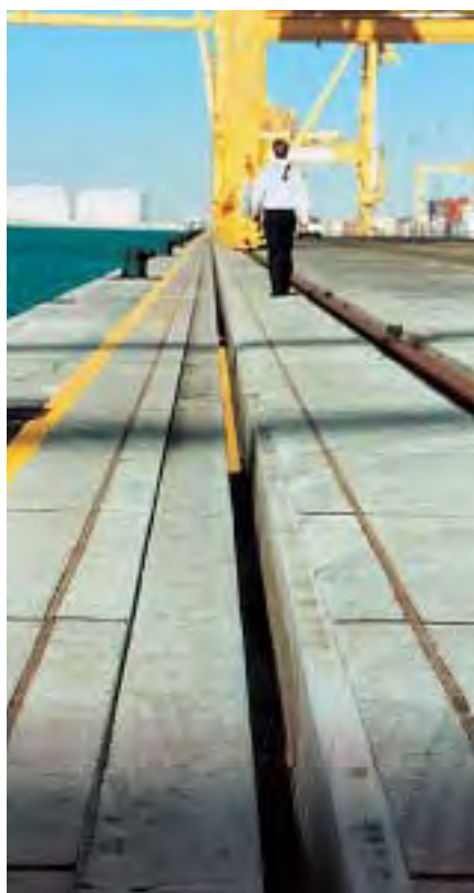
Порт Jebel Ali - Дубаи. Существующий канал, используемый для установки Panzerbelt.
